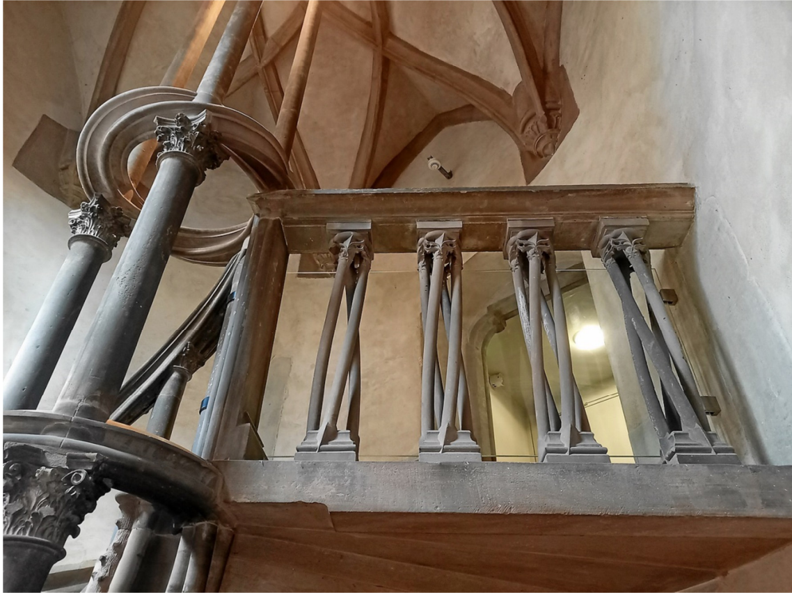
Oberer Treppenabschluß mit verdrehten Brüstungsstäben und in sich verdrehtem Ring über dem Treppenauge
