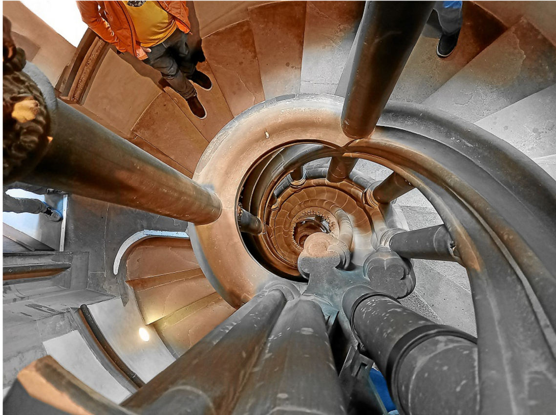
Treppenaug mit Geländer und Wangensäulchen
