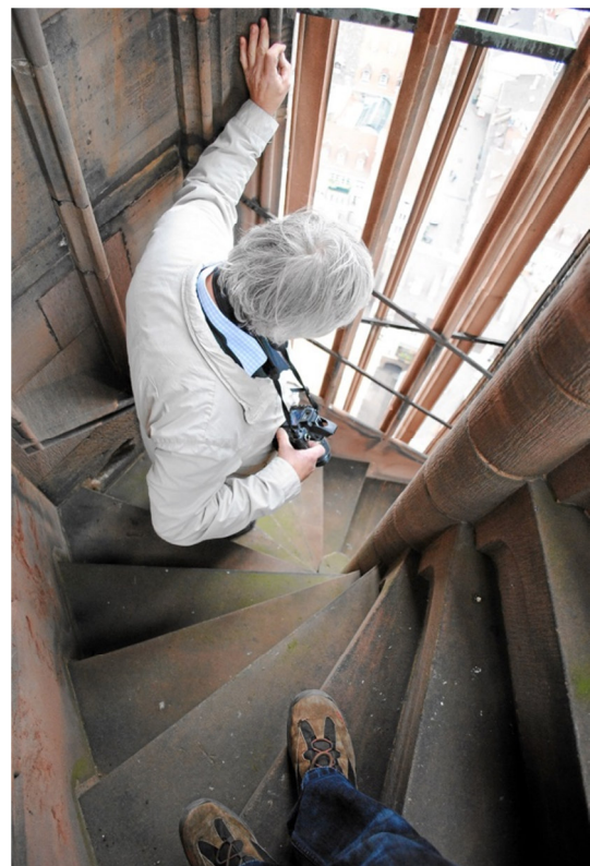
freistehende Spindeltreppen an den Außenecken des Turmoktogons
