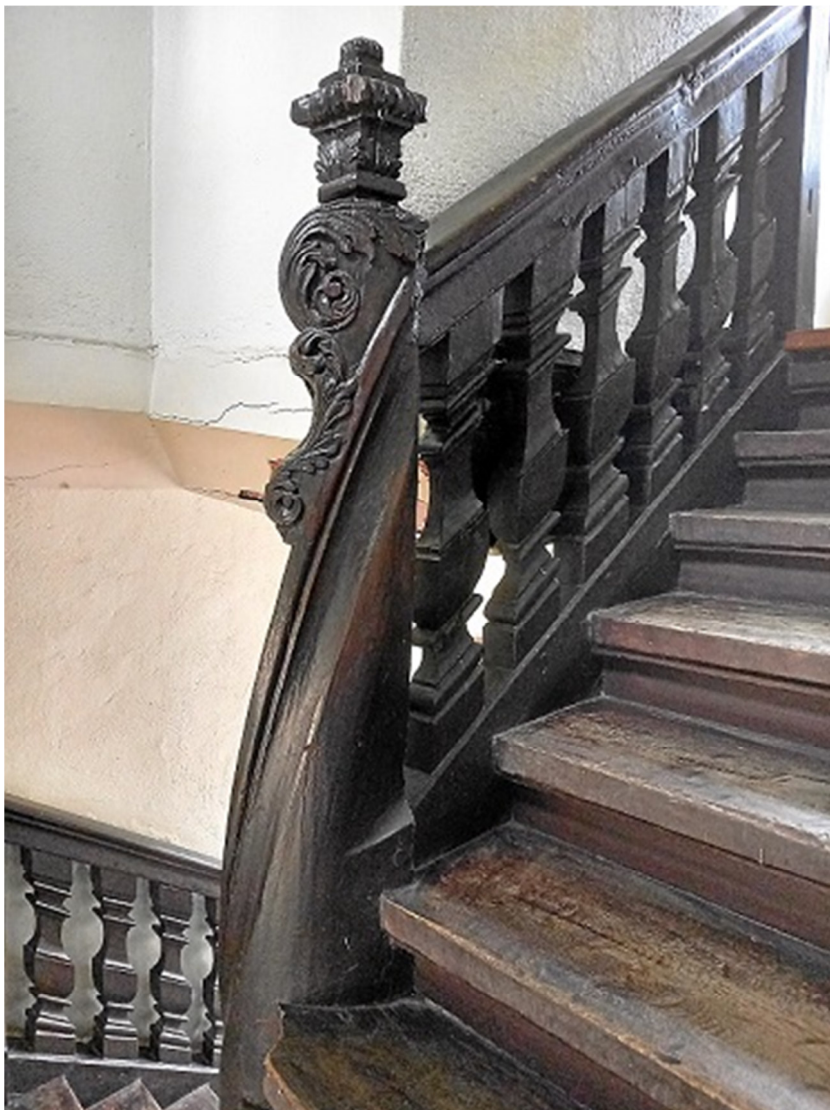
Wendelung Treppe 2.OG zum 3.OG
