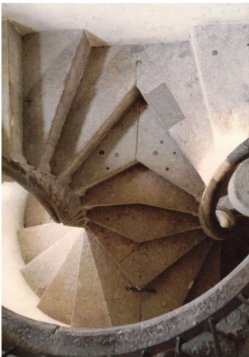
< Aufsicht der Treppenanlage
