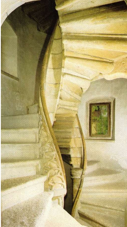
Seitenansicht der Treppenanlage
