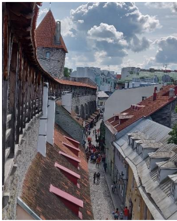
Ansicht der Mauer zur Stadtseite
