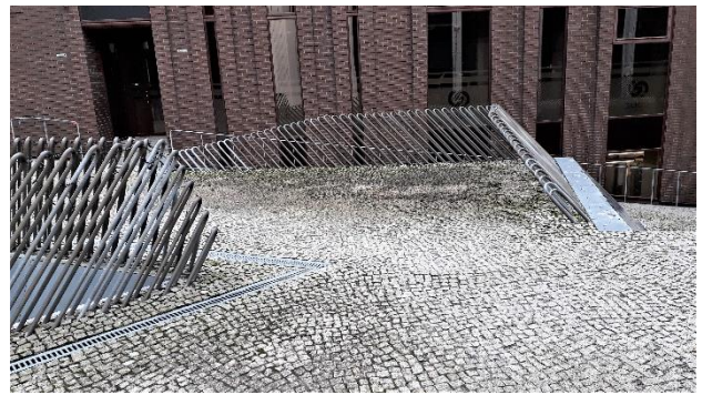
Brüstungsgeländer am Straßenrand
