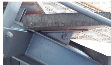
Stufenaufleger – li. Geländeranschluss
