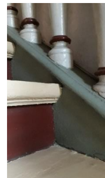
Stufenprofil und Dockenfuß
