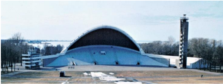
Dieser hyperbolische Paraboloid überspannt die Sängers-Loge mit einer Breite von 73 m und einer Höhe von 32 m
