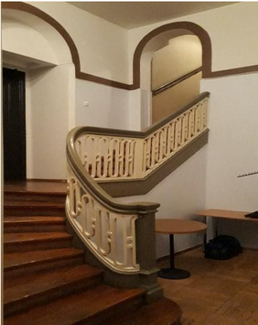
Treppe im ersten Obergeschoß
