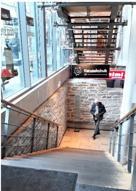
Treppenuntersicht EG zum OG und Kellertreppe
