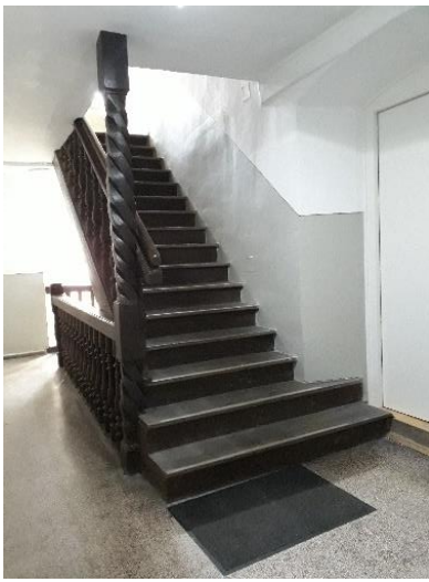
Austritt vom 2. Treppenlauf
