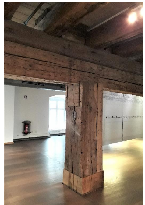
Abbildung der riesigen dicken Balken, Pfetten und Pfosten erkennbar
