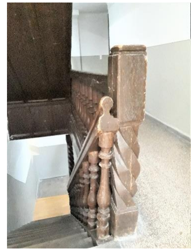
Austritt vom 3. Treppenlauf und unter Sicht der Dachbodentreppe
