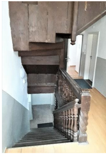
Antritt vom 3. Treppenlauf
