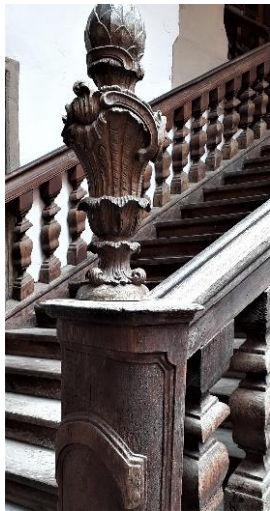
Pfosten am Zwischenpodest
