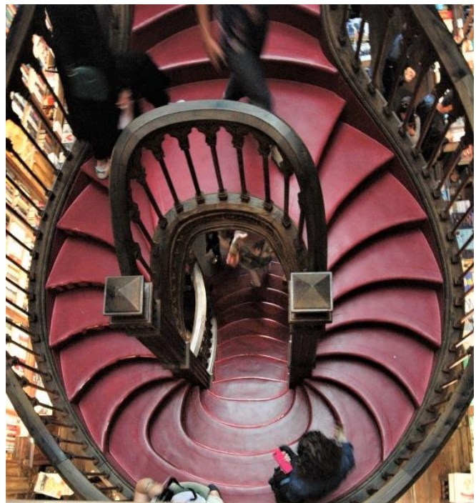
Der erste und die weiteren Treppenarme mit der Wendung
