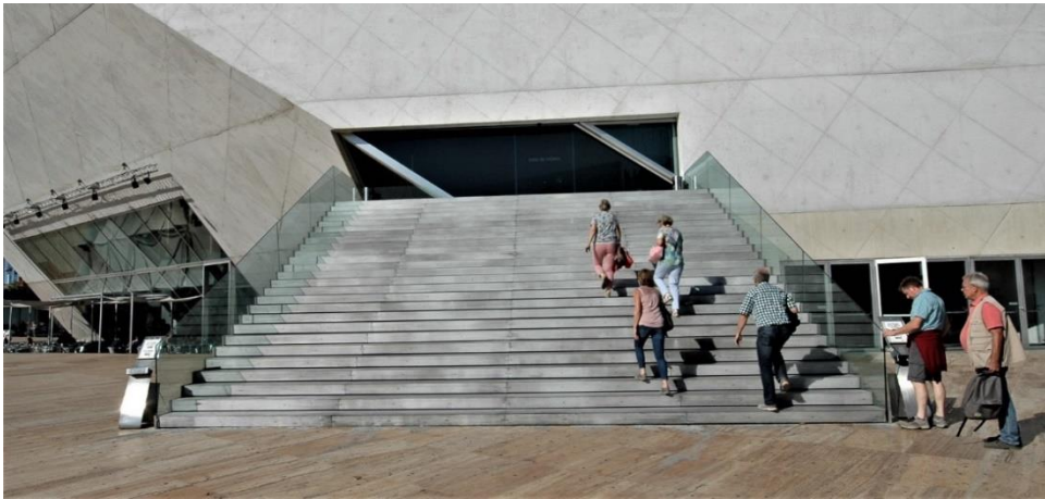
Außentreppe zum Halleneingang nach Europäischer Norm muss nach 18 Stufen ein Podest erfolgen. Diese hat 26 Stufen
