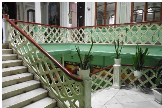
Zwischenpodest der zweiläufigen Treppe
