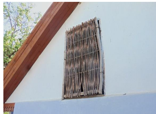
Öffnung am Haus, die mit Weidenästen geschlossen wurde
