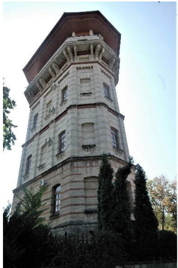
Wasserturm der Hauptstadt >
