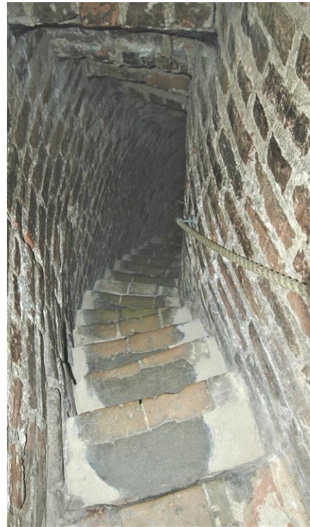
Der Treppenabgang im unteren Bereich der Treppenanlage
