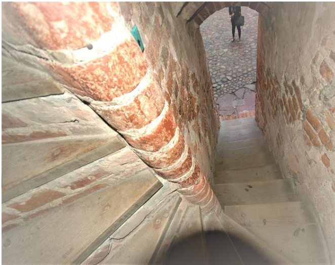
Der Treppenantritt ist im Hof
