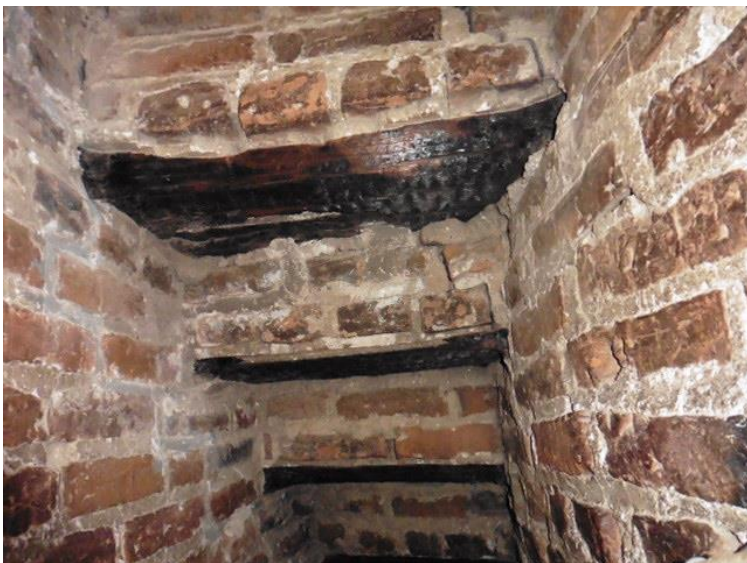
Im oberen Bereich des Turmes sind Holzbohlen als tragendes Element unter den Stufen eingebaut
