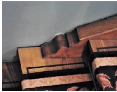
Profilierung der Wandwange am Treppenantritt
