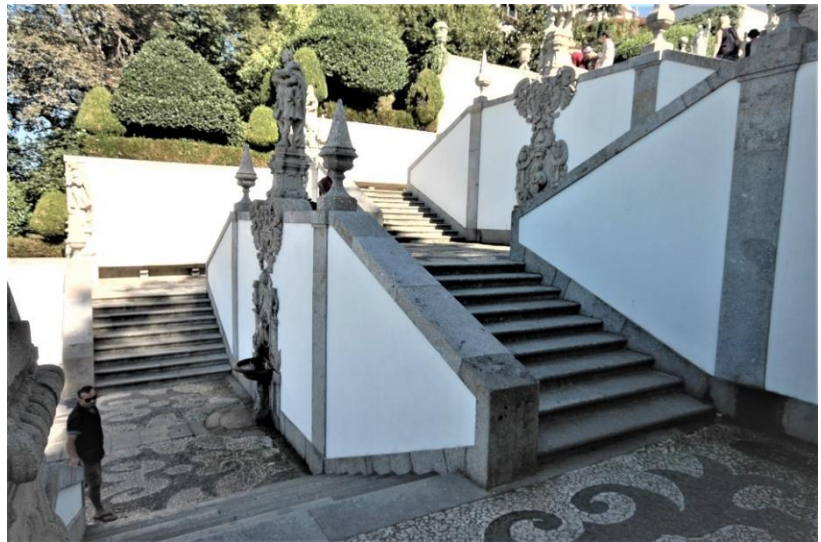
Aufnahme der Treppenanlage am Antritt
