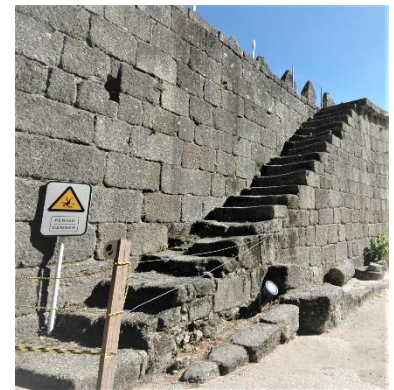
Treppe im Originalzustand wie sie in allen Burgen gebaut wurden
