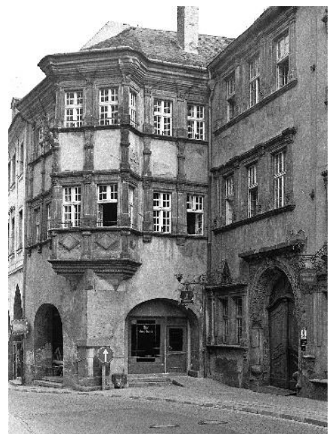
Der Zustand des Gebäudes von 1970
