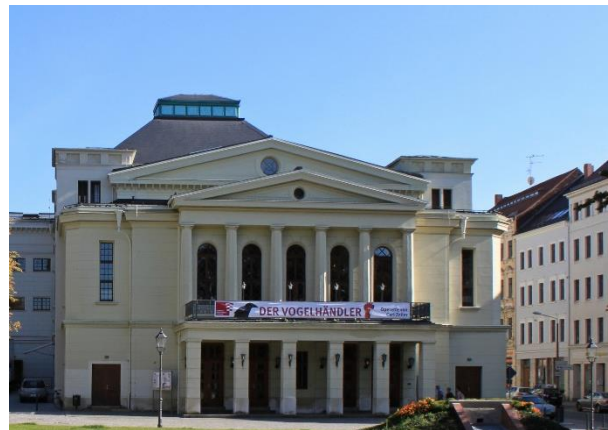
Eingangsfrent des Theaters Die beiden Bilder sind entnommen von Wikipedia
