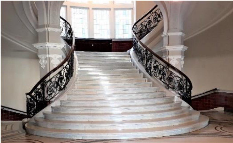
Die Treppenanlage ist ausgestattet mit gemeinsamen Antrittsarm, Zwischenpodest und zwei auseinander laufenden Armen
