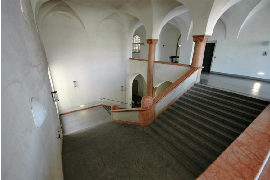
Das Seitentreppenhaus von Bestelmeyer 1907/09 Treppenbreite 385 cm Steigungsverhältnis 15/36 cm
