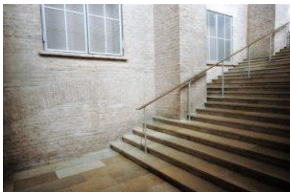
Das Zwischenpodest mit den zweiten Treppenarm
