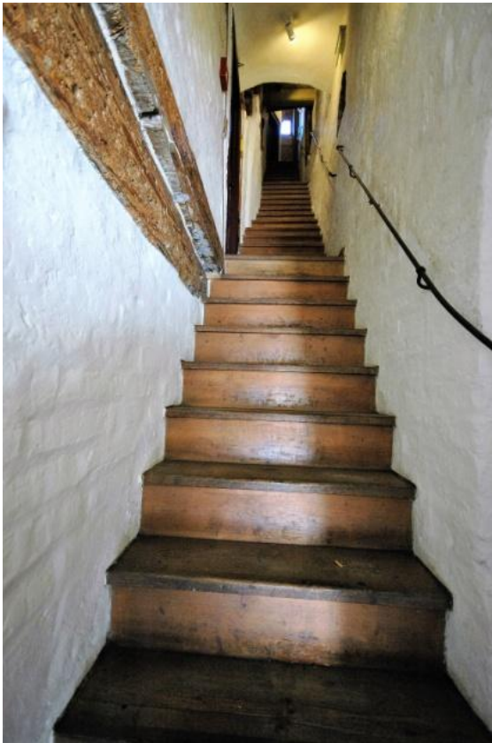
Der Treppenaufgang, mit Fenster zur Belichtung der Treppe
