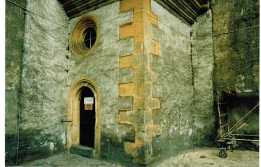
Rechter Seitenturm, Eingang zur Hölzerne Spindeltreppe
