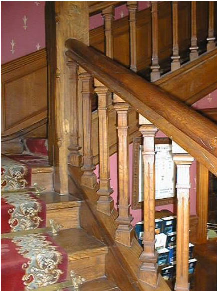
Quadratische Geländerstäbe mit einer Kannelierung, Sockel und Kapitell.
