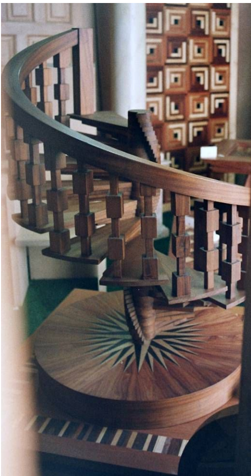
Spindelstiege mit Außengeländer
