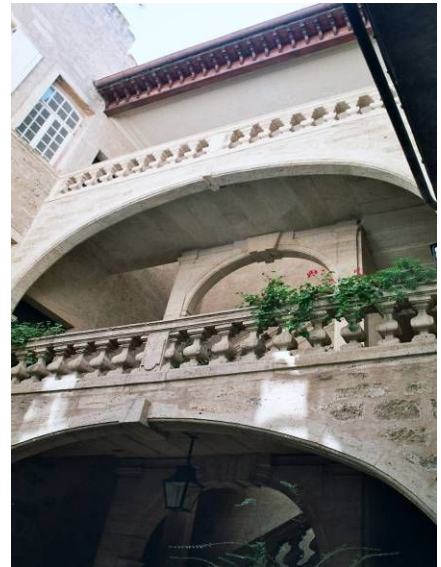
Die Ansicht der Treppenanlage von der Hofseite
