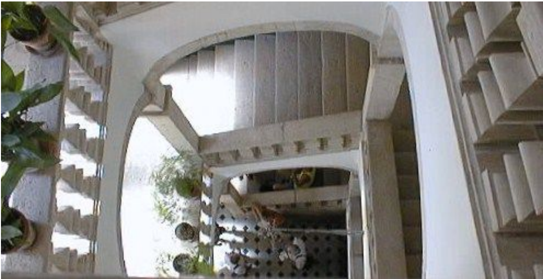
Ein Blick von oben nach unten ins Treppenauge
