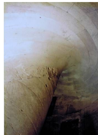
Unteransicht der Treppe
