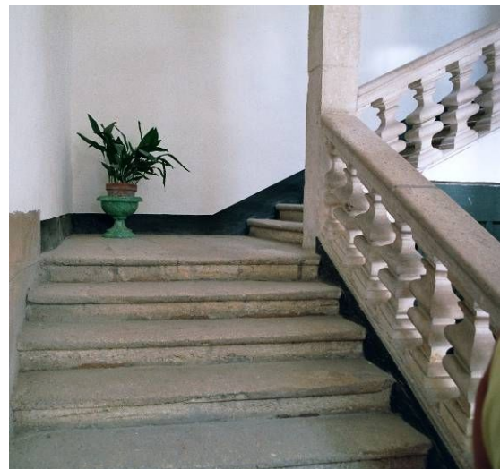
Der erste Treppenlauf mit Eckpodest
