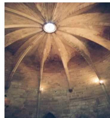
Die Belichtung des oberen Raumes erfolgt durch eine Öffnung in der Mitte des Kreuzrippengewölbes
