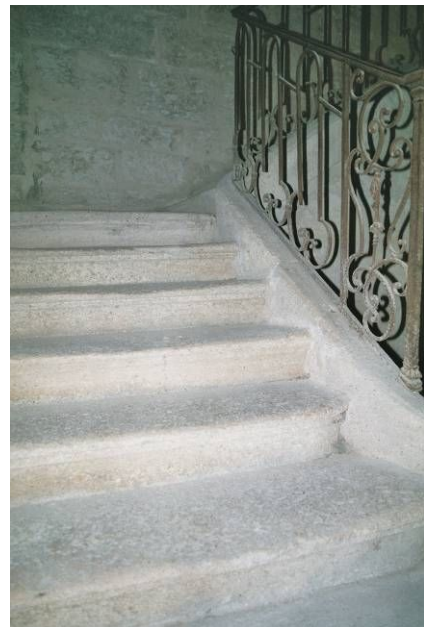
Die Stufenvorderkante weist ein typisches barockes Profil auf, ein Wulst von 5 cm und eine 2 cm hohe Platte mit Kehle in die Vertikale.
