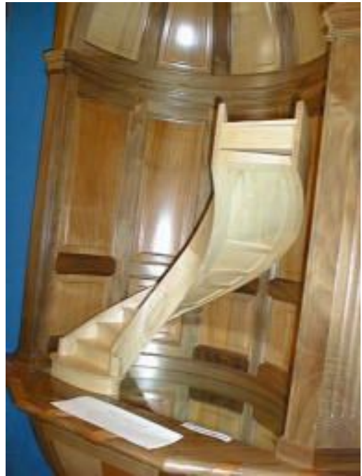
Die Treppe ist von der Unterseite geschlossen und profiliert
