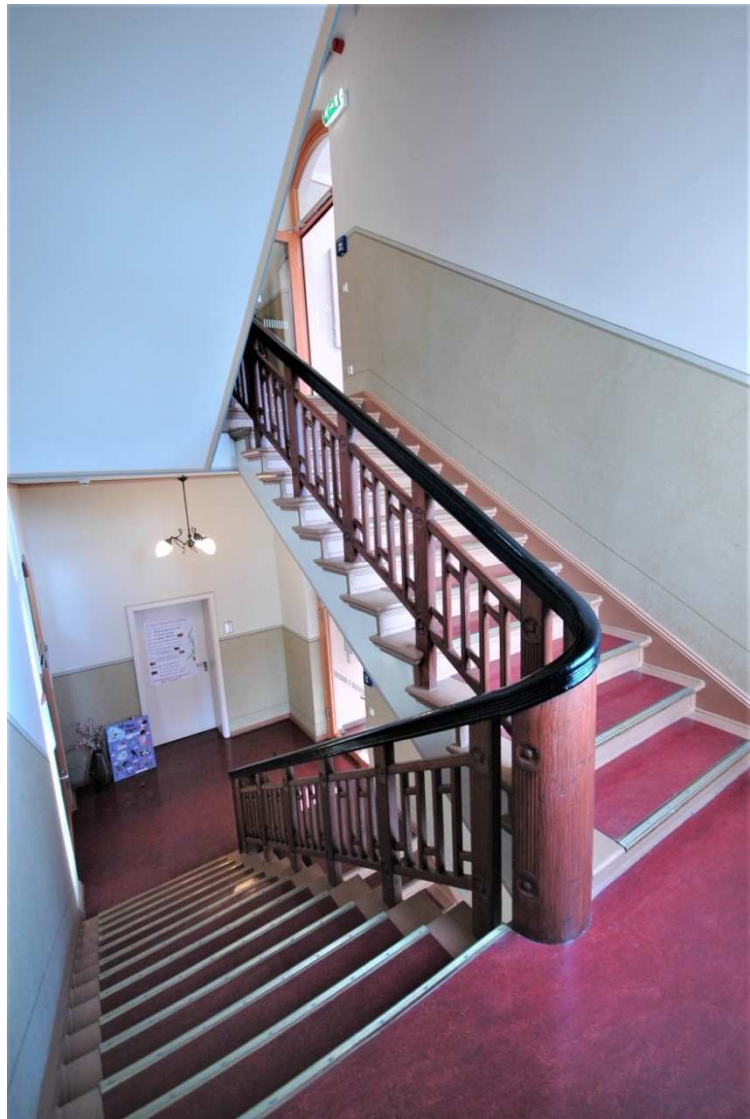
Treppenanlage vom EG zum 1.OG
