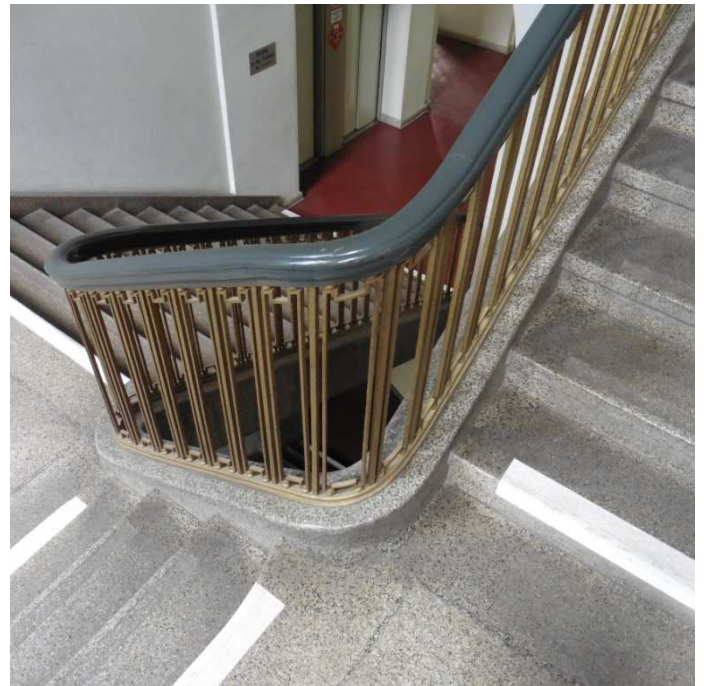
Treppe, 2. Obergeschoss, Wendelbereich
