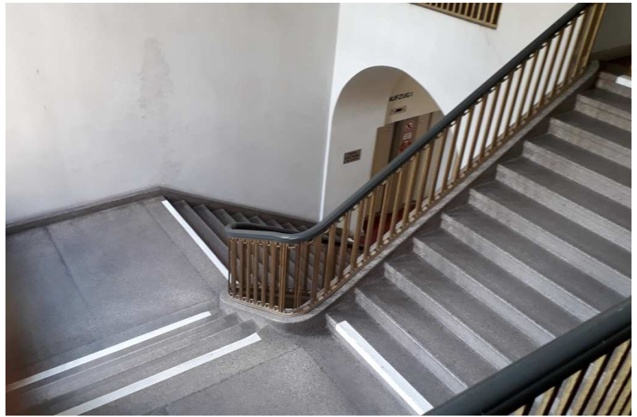
Dreiarmige Treppe vom 2. OG zum 3.OG
