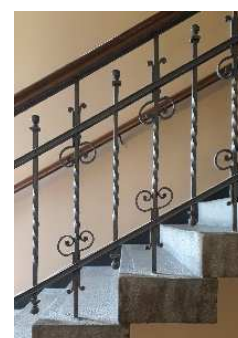
Ansicht Stufen und Geländer von der Freiseite
