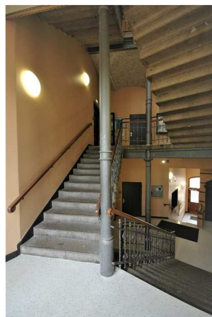
Anschluss der Treppenläufe am Wendepodest
