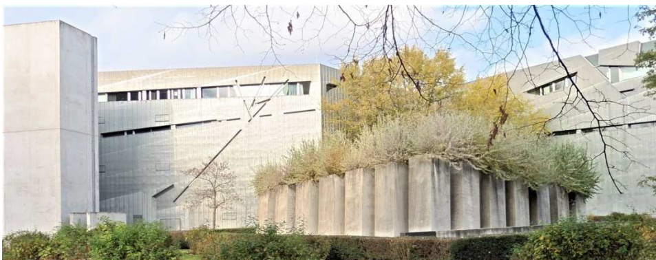
Die südliche Seitenansicht des Gebäudes
