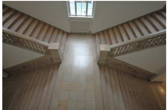
Blick auf das Verteilerpodest und den 4 Armen
