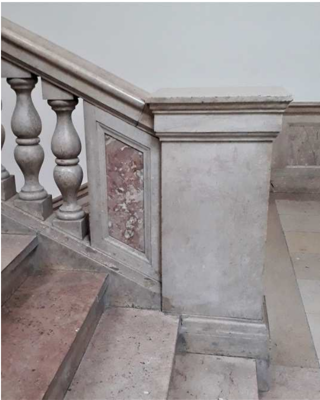
Geländer mit Pfosten und Baluster
