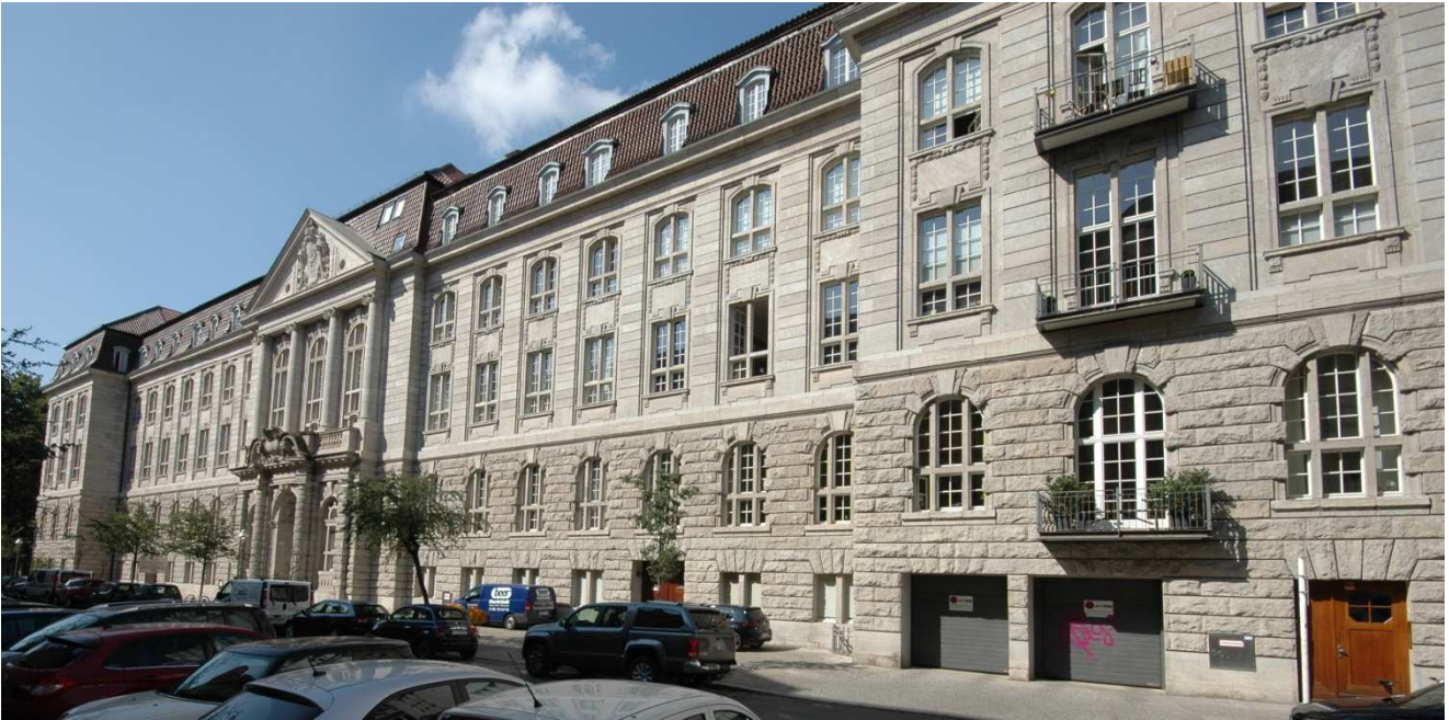
Das Gebäude des ehemaligen Reichsmilitärgerichts in der Witzlebenstraße 4 - 10, heute Wohnungen
