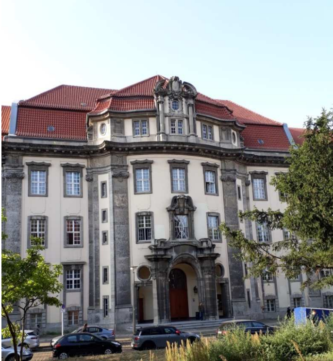
Der Haupteingang mit bekrönender Laterne ist auch der Mittelpunkt des Gebäudes
