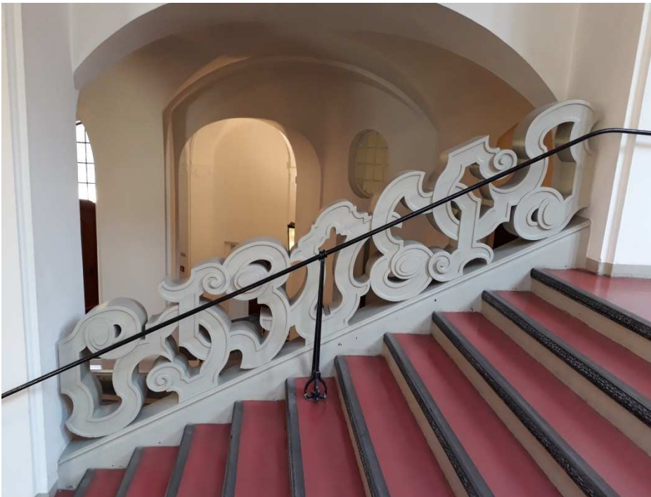
Das Steigungsgeländer besteht aus einem Bandornament
