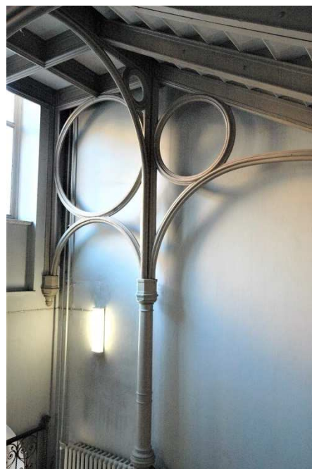
Podestuntersicht von der Obergeschoß Treppe
