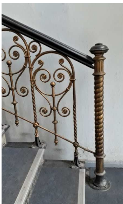
Wandseitiges Treppengeländer von der Obergeschoß Treppe
