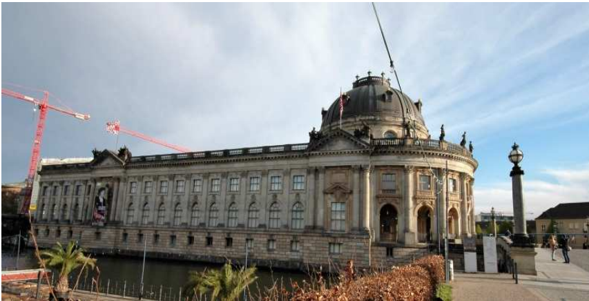
Seitenfront zum Hauptarm der Spree, rechts die Brücke mit dem Haupteingang des Museums
