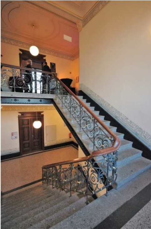
Gegenläufige Treppe mit Wendepodest
