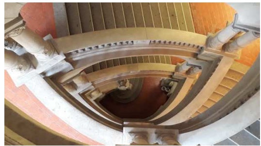
Die beiden Treppenaugen zwischen den Treppenarmen haben die Maße von 4,80 m x 2,52 m
