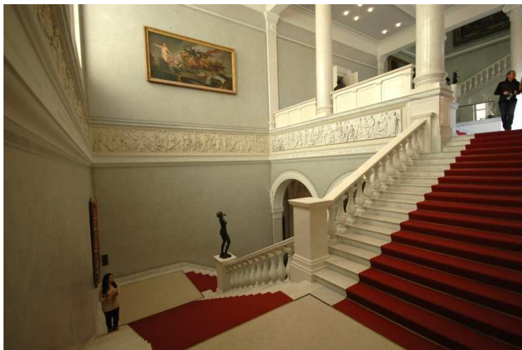
Treppe zum ersten Obergeschoss wurde im zweiten Weltkrieg zerstört und 1998 - 2001 wieder restauriert
