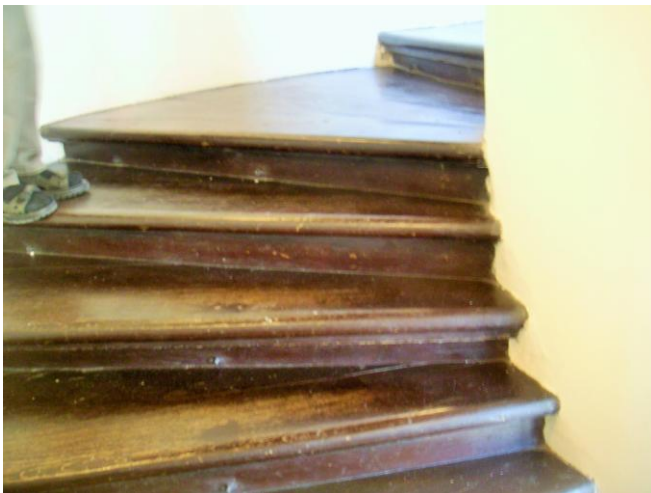
Stufenoberseite; an die Stufenvorderkante ist ein typisches barockes Profil mit Wulst und Kehle gearbeitet
