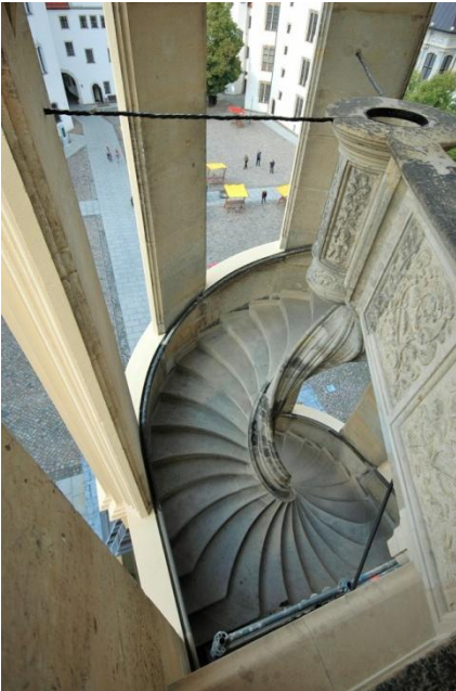
Der Treppenübergang vom zweiten in den dritten Stock
