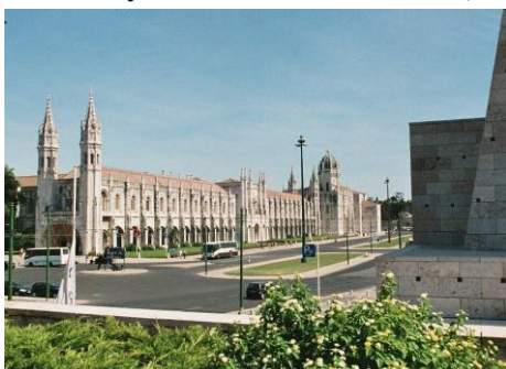
Der Links westliche Teil ist Kloster, der Rechte östliche Teil Kirche
