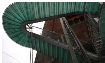
Unteransicht der Oberen Treppenläufe
