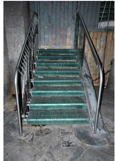
Treppen Antritt im Gebäude
