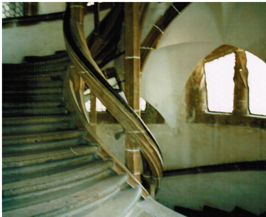
Die Verziehung des Handlaufe ist ein handwerkliches Können das damals wie heute nur wenige Handwerker beherrschen
