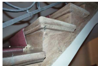
Ein Detail der Tritt- und Setzstufe mit Blendwange.
