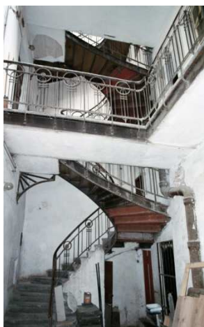
Die Treppenanlage verbindet zwei Etagen miteinander, sowie ein Anschluss zum Seitengebäude.
