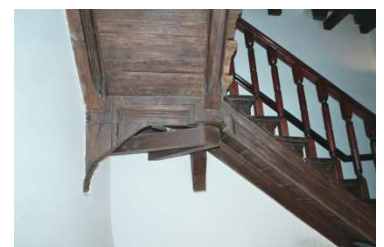
Die Treppenunterseite, mit der nachträglichen U- Stahlstütze
