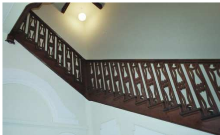
Die EG. Treppe ist gestützt durch eine unter den Holm auf der Freiseite stehenden Wand.
