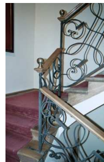
Ein Detail der Tritt- und Setzstufe mit Blendwange.
