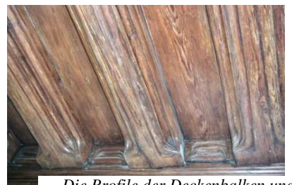
Die Profile der Deckenbalken und Holme sind identisch.
