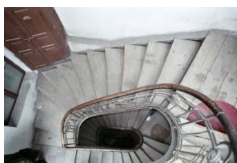
Ein großes Treppenauge sorgt für eine ausreichende Belichtung der EG Treppe
