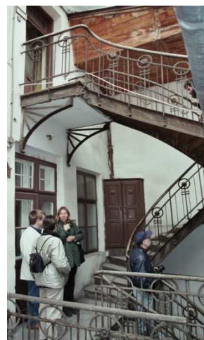
Die Abstützung der Austrittspodeste zu den Wohnungseingängen ist liebevoll hergestellt.
