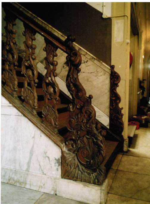
Antrittspfosten im Erdgeschoß
