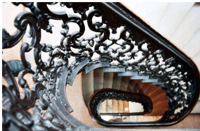
Der Treppenbauer ging an das technisch Mögliche um die Stabilität zu gewährleisten.
